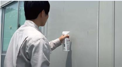
施工対象基材に汚れ、塵、埃、水分、油分、洗剤が残らないように水や雑巾を使用し、きれいに清掃する。
