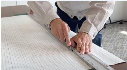
先にサイズを決めてカット。最後にスコッチカルフィルムで端部処理を行うため、貼付対象より上下 10mm (エッジコートの場合は 5mm) 程度短くカットする。
