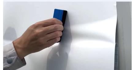
残りの剥離紙も起点側から少しずつ剥がし、スキージーで中央から左右に空気を逃すようにして貼り進める。※貼付に際し、フィルムにテンションをかけないよう注意してください。
