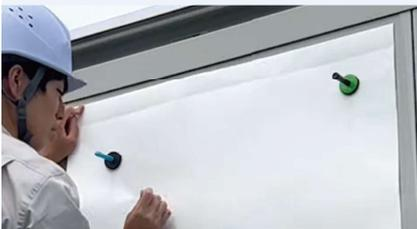
剥離紙を剥がさず、施工対象より上下左右 10mm (エッジコートの場合は 5mm) 程度の隙間ができるようにフィルムを配置し、マグネットで固定する。
