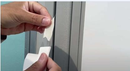
フィルム端部と基材にまたがる様に、スコッチカルフィルム (またはエッジコート) を施工する。エッジコートは施工部分をマスキングテープで囲うときれいに施工できます。
