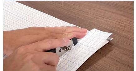
剥離紙カッターを使い、貼付の起点部分の剥離紙を 50mm 程度の幅でカットする。剥離紙は剥がさず残しておく。
