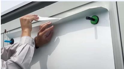
フィルムの貼付位置が決まったら、手順3でカットした起点部分の剥離紙を剥がし、貼り付けて固定する。
