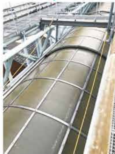
改修後 MAMORI・21N 塗装完了 乾燥後は透明に変化
