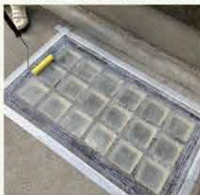
耐水コートを砂骨ローラー塗装
