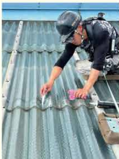
充填後のヘラ押え作業
