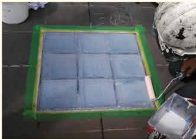
トップコート(防滑剤含む)を中毛ローラー塗装
