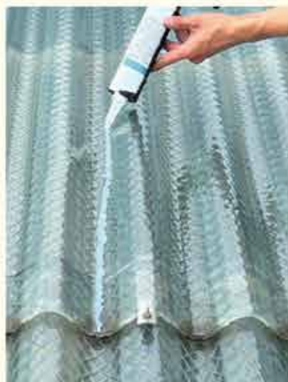
ひび割れ部に沿ってHS 充填
