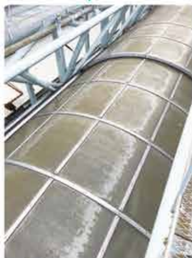
改修前 トップライト外観
