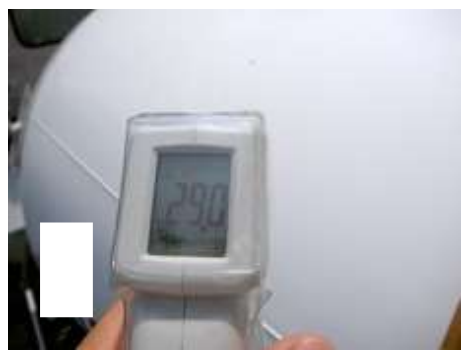
施工車表面温度 (29.0 度)
