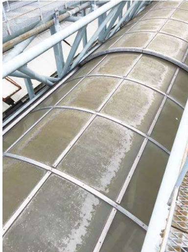
改修前 トップライト外観
